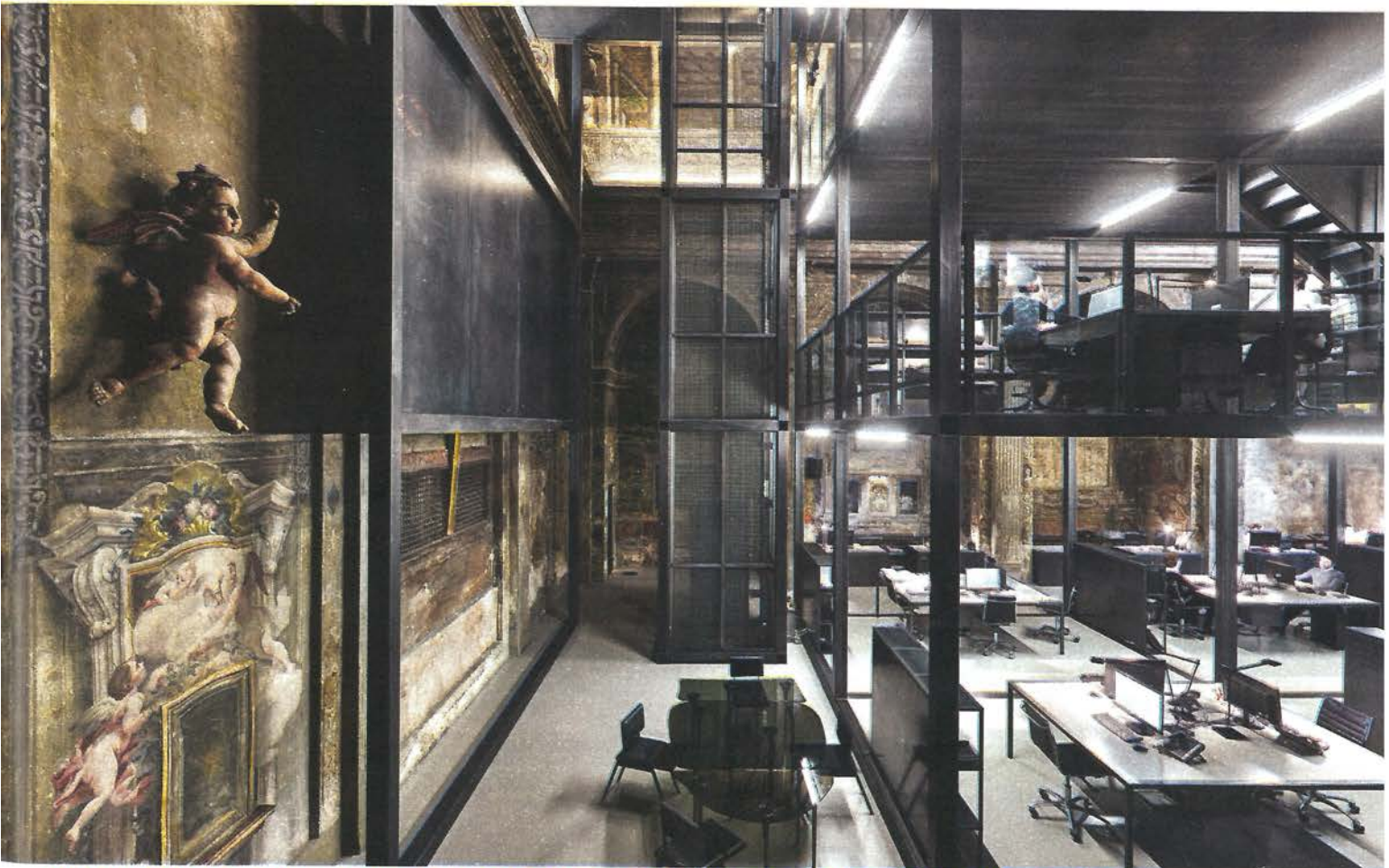
Un particolare della struttura di quattro piani che ospita le scrivanie degli architetti nella chiesa di San Paolo Converso.
